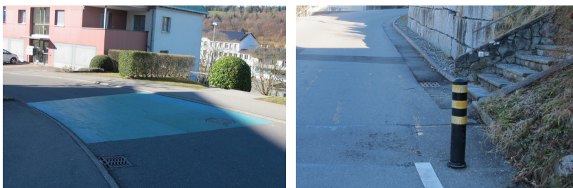
Abb. 33 / 34: Wyden- und Mühlehofstrasse: Referenzmassnahmen, um einmündende Fusswege zu sichern, die als Schulwege dienen.
