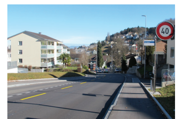
Abb. 12: Schösslistrasse mit Tempo 40 im Bereich Bushaltestelle Mühlegg
