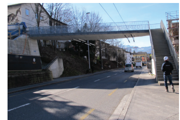
Abb. 22: Überführung Schachen an der stark befahrenen Luzernerstrasse
